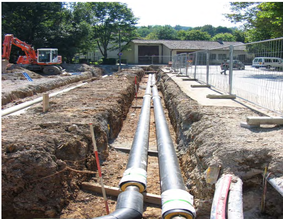
fig. 44. Pozita e tubacioneve në kanal
