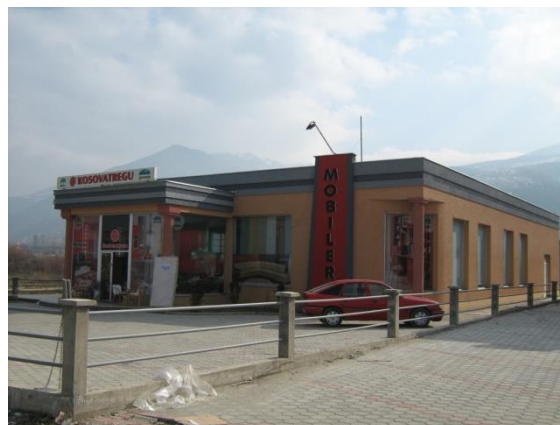
Fig. nr.13 Objekti në ndërtim e sipër
