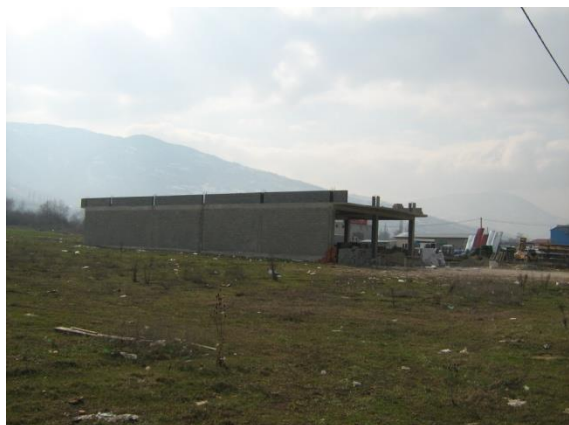
Fig. nr.12 Objekti në ndërtim e sipër
