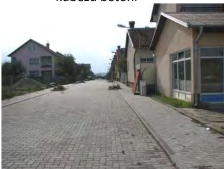
Foto 13. Rrugë e shtruar në kubëza betoni
