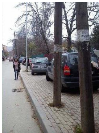
8. SHTYLLA ELEKTRIKE DHE VETURA NË TROTUAR
